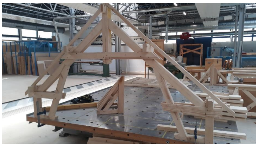
Construction bois LPo VIOLLET LE DUC Villiers saint Frédéric 78
