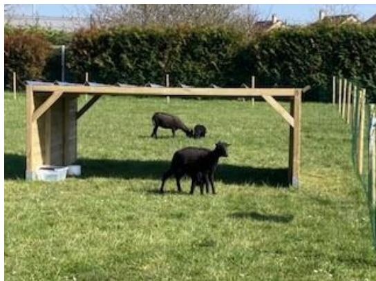
Abris à mouton pour un collège par le LP Auguste PERRET Évry 91
