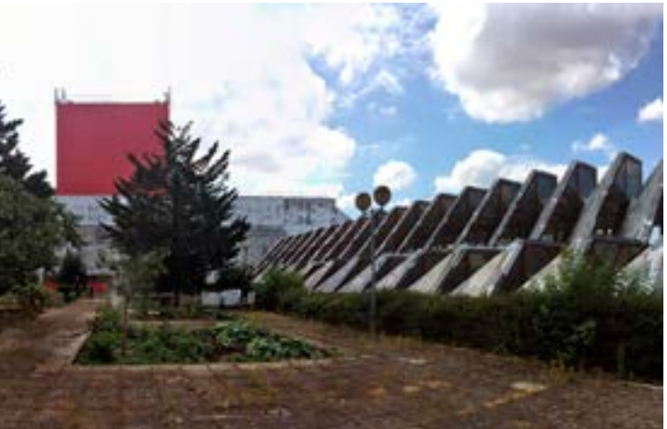
toit terrasse de la halle des Grésillons accessible par le T2G @ Liliana Motta 2018
